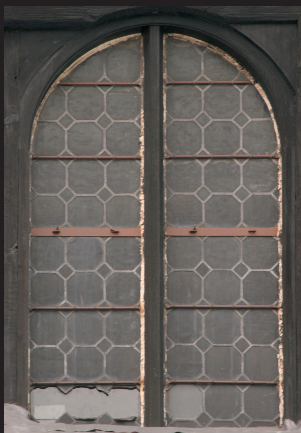
2, 3: Schäden an den Fenstern der Friedenskirche Schweidnitz Uszkodzenia w oknach kościoła Pokoju w Świdnicy
