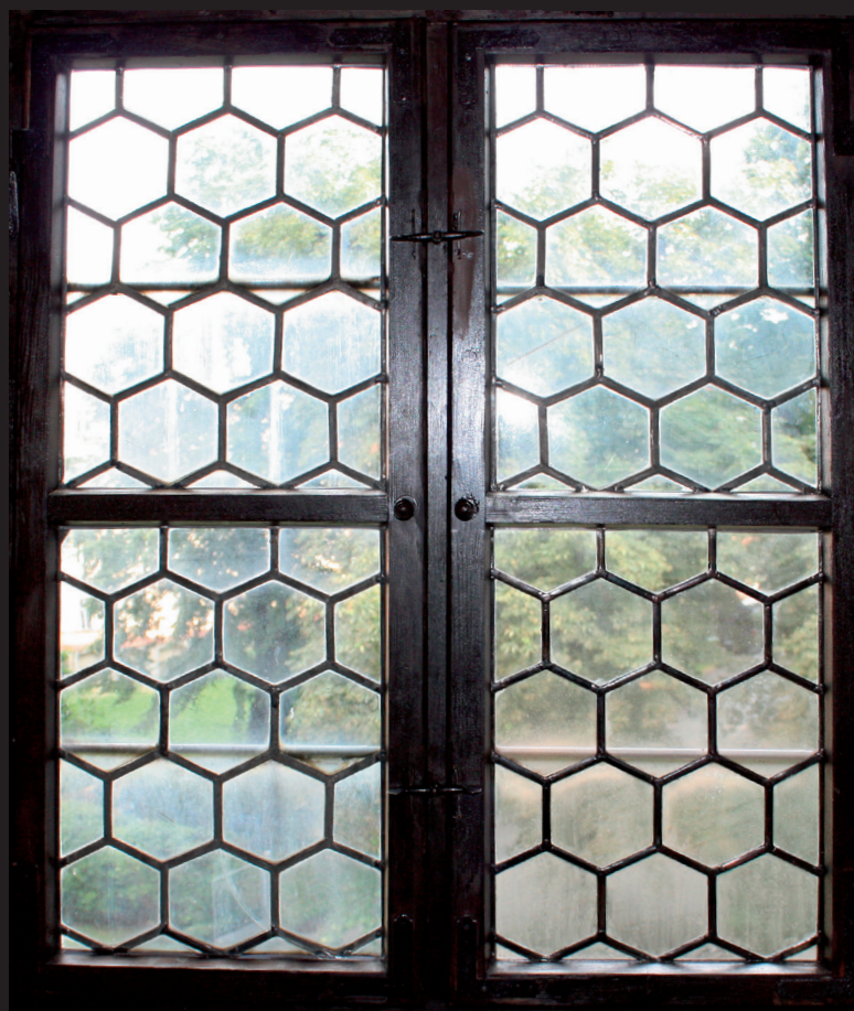
4, 5: Fenster vor und nach der Restaurierung Okno przed i po konserwacji
